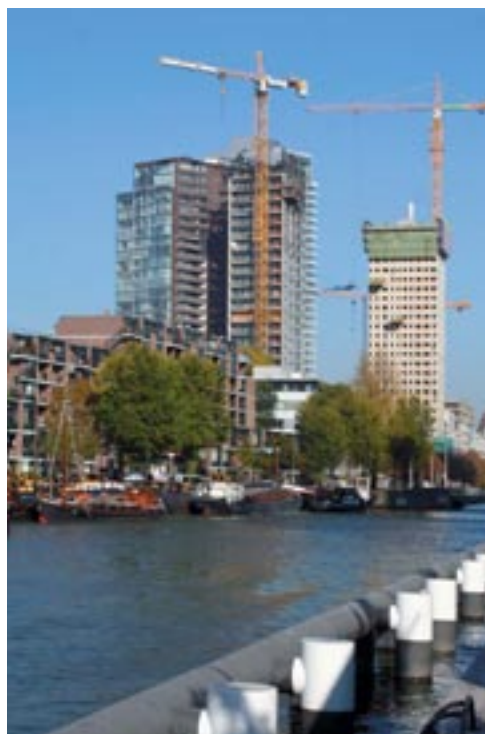
Met de Waterstadoren (2004) op het Rotterdamse Wijnhaveneiland realiseerde ons land de eerste prefab woontoren in Europa die de barrière van honderd meter hoogte slechte. Inmiddels zijn er vlak naast al weer twee in hoogte concurrerende gestorte torens in aanbouw, de Scheepmakerstoren en The Red Apple.
